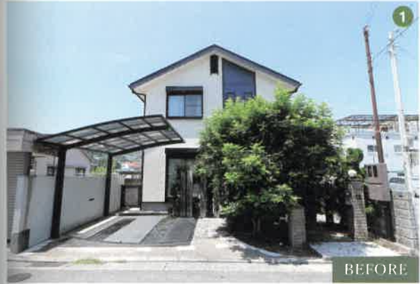
①施工前。大きくなりすぎたシンボルツリーが通路をふさいでいました。②施工後のファサード。全体にすっきりモダンな門まわりに生まれ変わりました。
