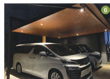
③④カーポートはご要望の木調タイプをセレクト。柱は車の邪魔にならないように配置しています。⑤⑥⑦ダウンライトは6カ所に施工。夜でも安心して車が停められます。⑧施工前の駐車場。⑨施工前のファサード。⑩ファサード。建物にマッチしたカーポートです。
