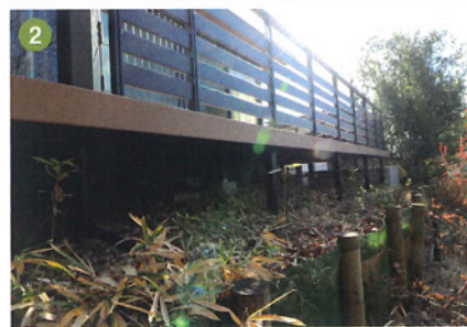
①②斜面に施工したデッキの足元。しっかりとしたつくりです。
