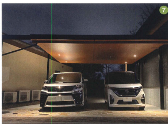
③④カーポートはご要望の木調タイプをセレクト。柱は車の邪魔にならないように配置しています。⑤⑥⑦ダウンライトは6カ所に施工。夜でも安心して車が停められます。⑧施工前の駐車場。⑨施工前のファサード。⑩ファサード。建物にマッチしたカーポートです。
