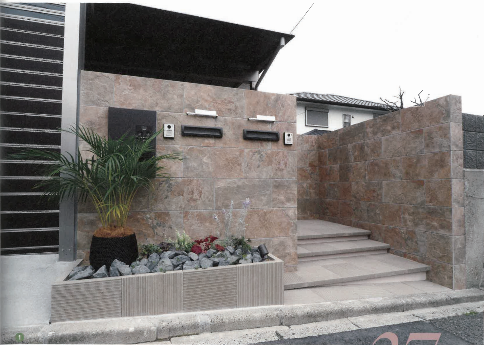
①門まわり全景。タイル貼りの迫力ある門柱に、植栽のグリーンが優しい印象をプラスして。②施工前。
