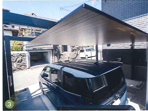
①エクステリア全景。②夜になるとカーポートに取りつけられたダウンライトとラインライトが点灯して、駐車場とアプローチを明るく照らします。③④カーポートの柱がアプローチを邪魔することがないように、梁を延長。⑤反対側の柱も、駐車場の外側の砂利スペースにできるように設置。駐車の際の妨げになりません。⑥施工前。
