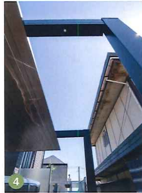
①エクステリア全景。②夜になるとカーポートに取りつけられたダウンライトとラインライトが点灯して、駐車場とアプローチを明るく照らします。③④カーポートの柱がアプローチを邪魔することがないように、梁を延長。⑤反対側の柱も、駐車場の外側の砂利スペースにできるように設置。駐車の際の妨げになりません。⑥施工前。
