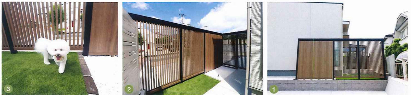
①道路側には、LIXIL「プラスG」のスクリーンとフェンスを組み合わせた目隠しを設置。②③スクリーンの下側に隙間がないように施工したことで、愛犬が外に飛び出す心配がありません。④⑤出入り口には、下側にレールが必要ない吊り引き戸を採用。錠つきで、セキュリティ対策も万全です。⑥⑦施工前。⑧全景。大きなスクリーンを設置しながらも、建物と調和した程良い抜け感があることで、圧迫感のない仕上がりになっています。
