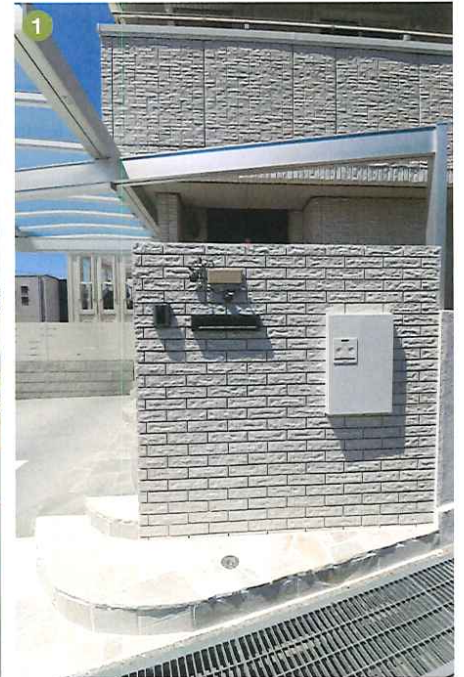
①建物外壁に似たタイルを採用した、リフォーム後の門柱。②既存の門塀はきれいな白色に塗り直し、その一部を削ったスペースに新たな門柱を施工しています。
