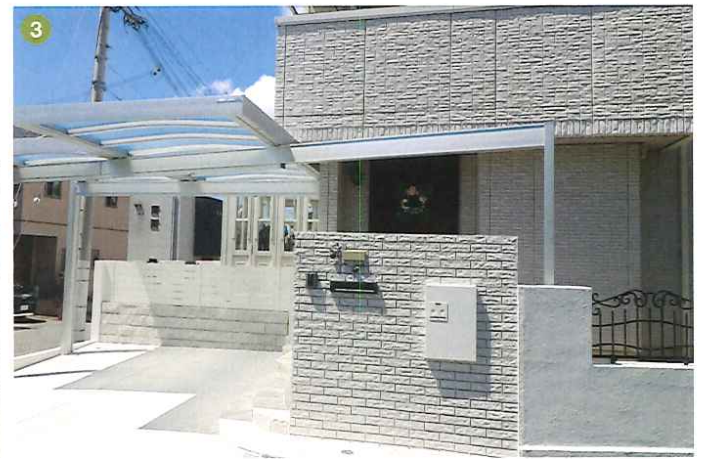
①建物外壁に似たタイルを採用した、リフォーム後の門柱。②既存の門塀はきれいな白色に塗り直し、その一部を削ったスペースに新たな門柱を施工しています。
