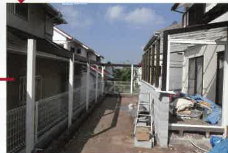
施工中。手入れの手間のかかる植栽を一掃。
