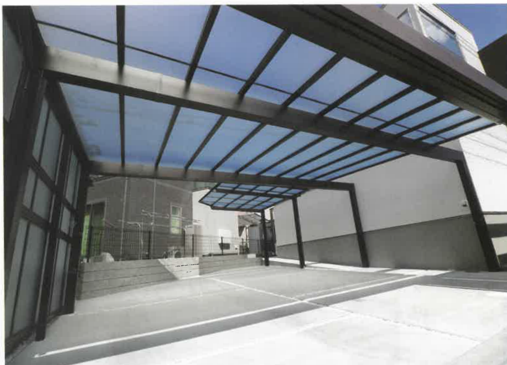
車3台が余裕とめられる大型カーポート。
